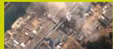
Splijfstofopslagbassins in centrales 1-4
