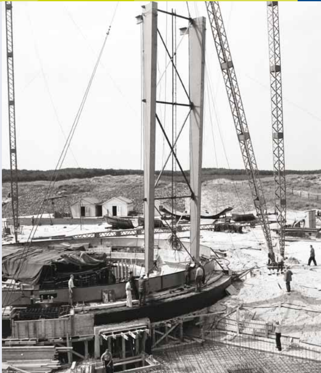
HFR in aanbouw
