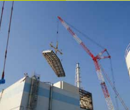
Plaatsen laatste dakpaneel op unit 1
