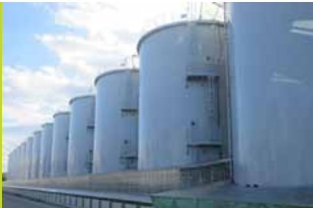
➤ Opslag tanks voor gecontamineerd water
