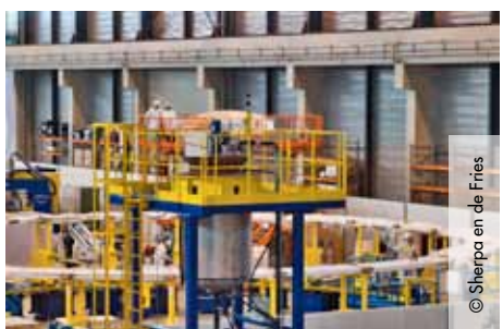
➤ Zicht op werkplatform in de centrale werkhal
