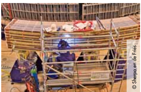
➤ Laswerkzaamheden in de centrale werkhal
