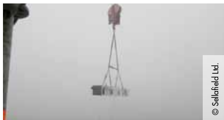
➤ De torenkraan voert het eerste brok beton af.
