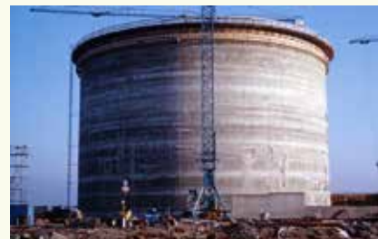
➤ De kerncentrale Borssele in aanbouw.
