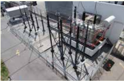
➤ De nieuwe netaansluiting op 380 kV (Foto Petar Curcic, medewerker EPZ)
