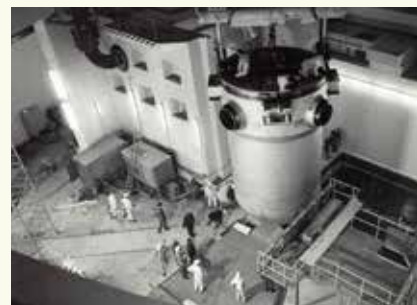
➤ In 1969 wordt het reactorvat geplaatst.
